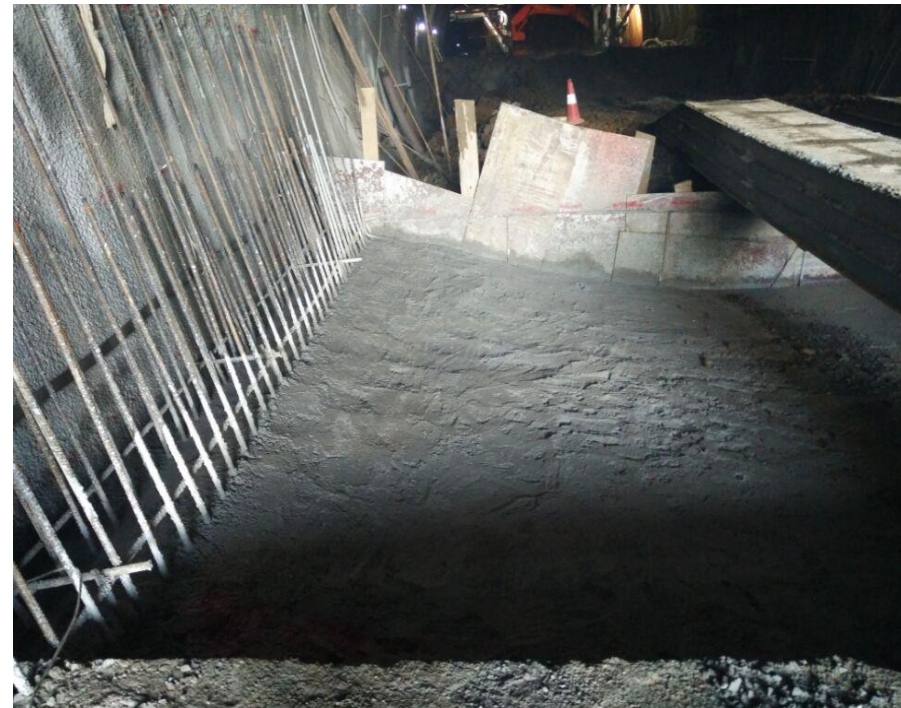
Pengecoran beton
