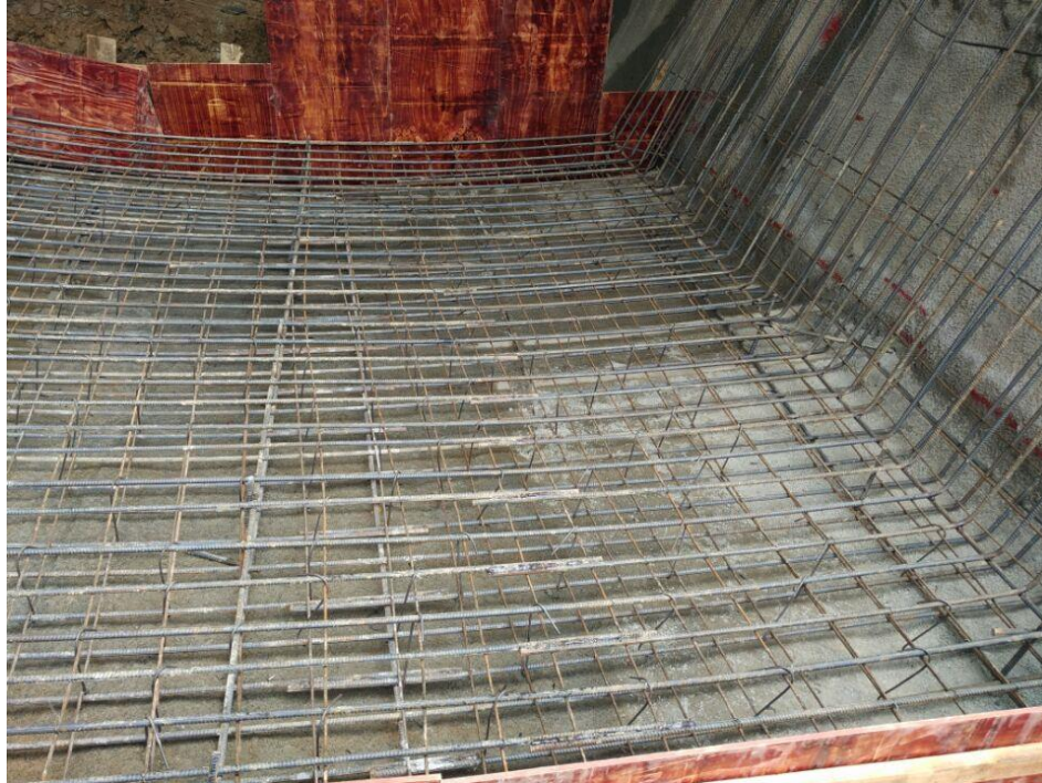
Penulangan pada bagian invert
