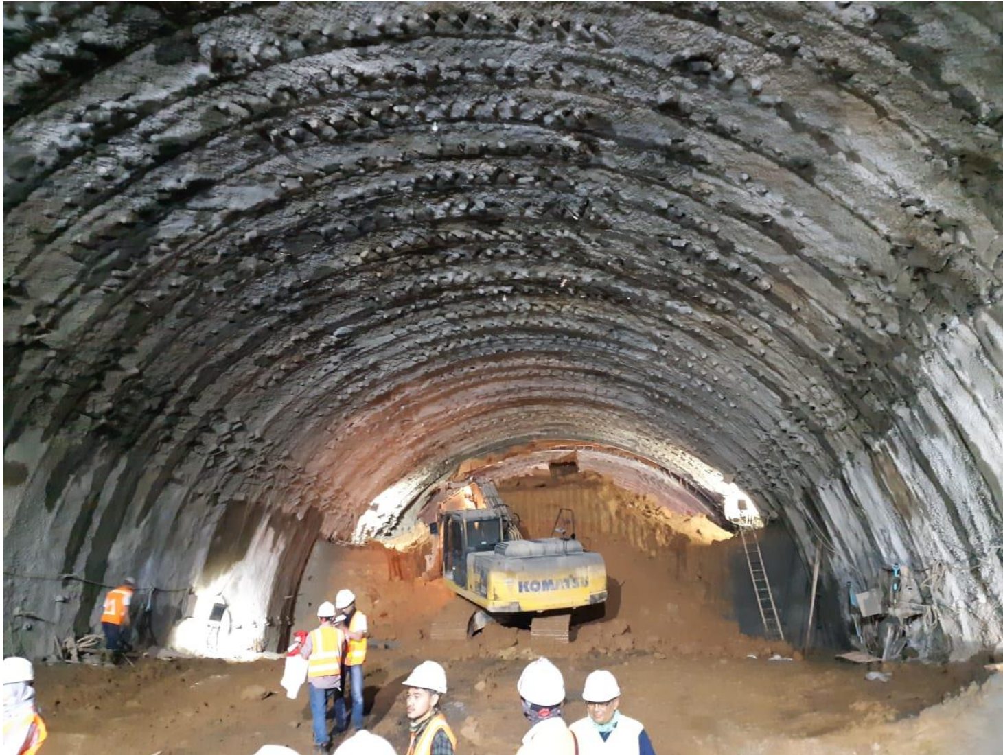
Perkuatan pada bagian atas dan samping terowongan
