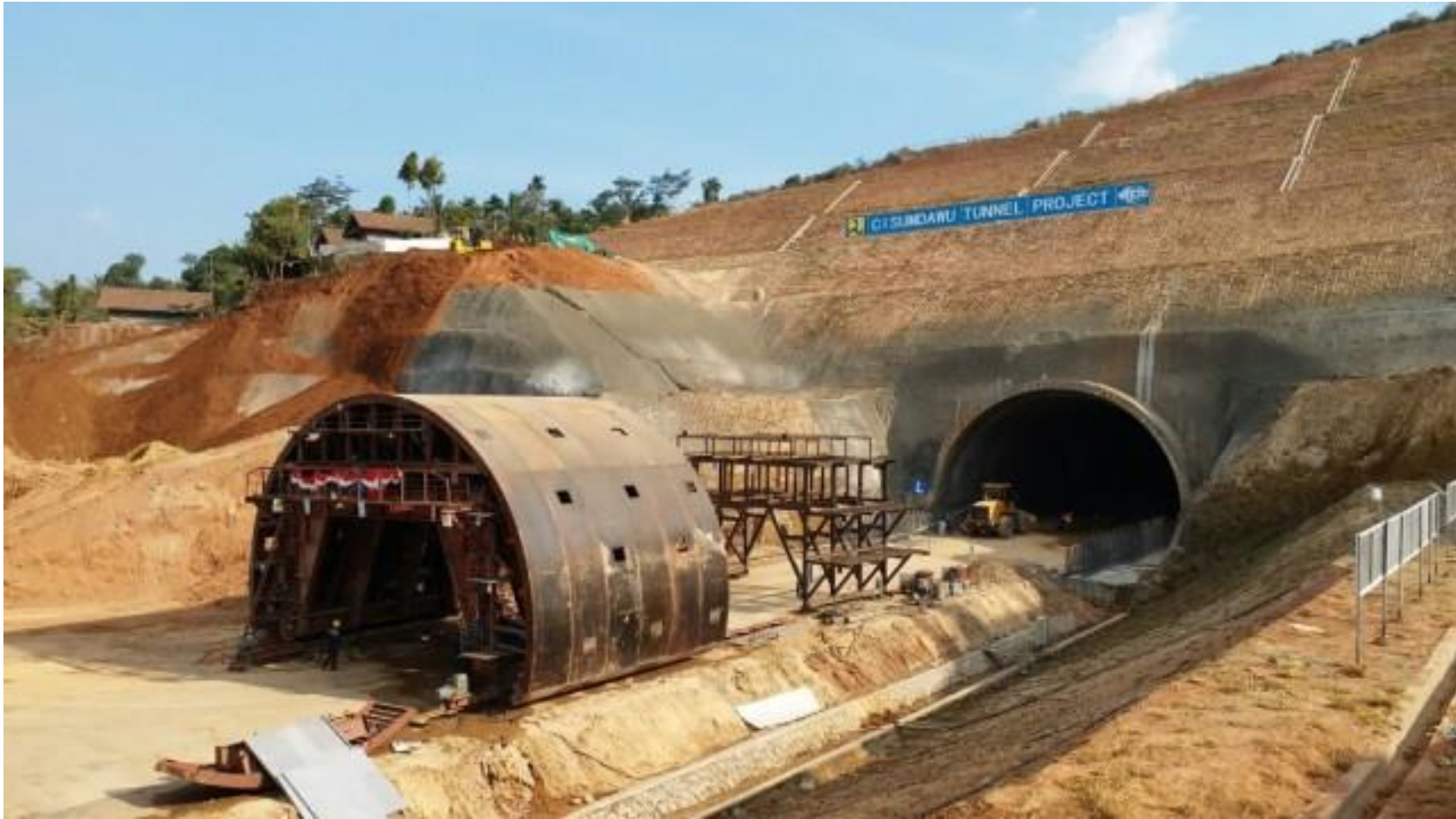
Penyiapan Formwork di bagian portal terowongan
