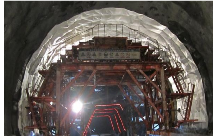
Pemasangan lapisan kedap air
